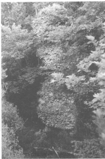
Εἰκ. 3. Τό δυτικό πόδι, ἀπό τή μέσα πλευρά τῆς καμάρας.
