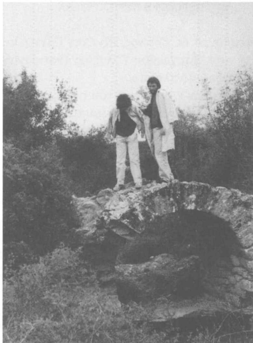
Εικ. 3. Σιτοχώρι: γέφυρα στην τοποθεσία Ευλόστρατα.
