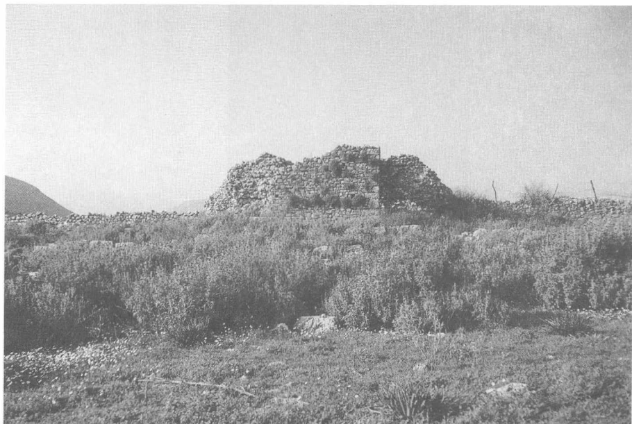
Εικ. 3. Πύργος στο νότιο τείχος
