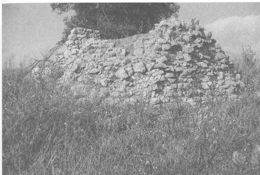
Εικ. 4. Πύργος στο νότιο τείχος
