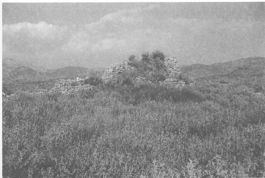
Εικ. 5. Πύργος στο νότιο τείχος
