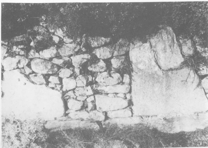
Πίν. 23. α. Λεπτομέρεια του τοίχου. β. Η είσοδος (φωτογρ. Π. Φάκλαρη).
