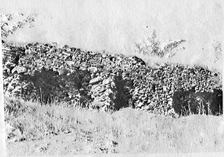
Τό κάστρο τοῦ Μελάνθιου. Ν. πλευρά. Δεῖγμα τοιχοποιίας.
