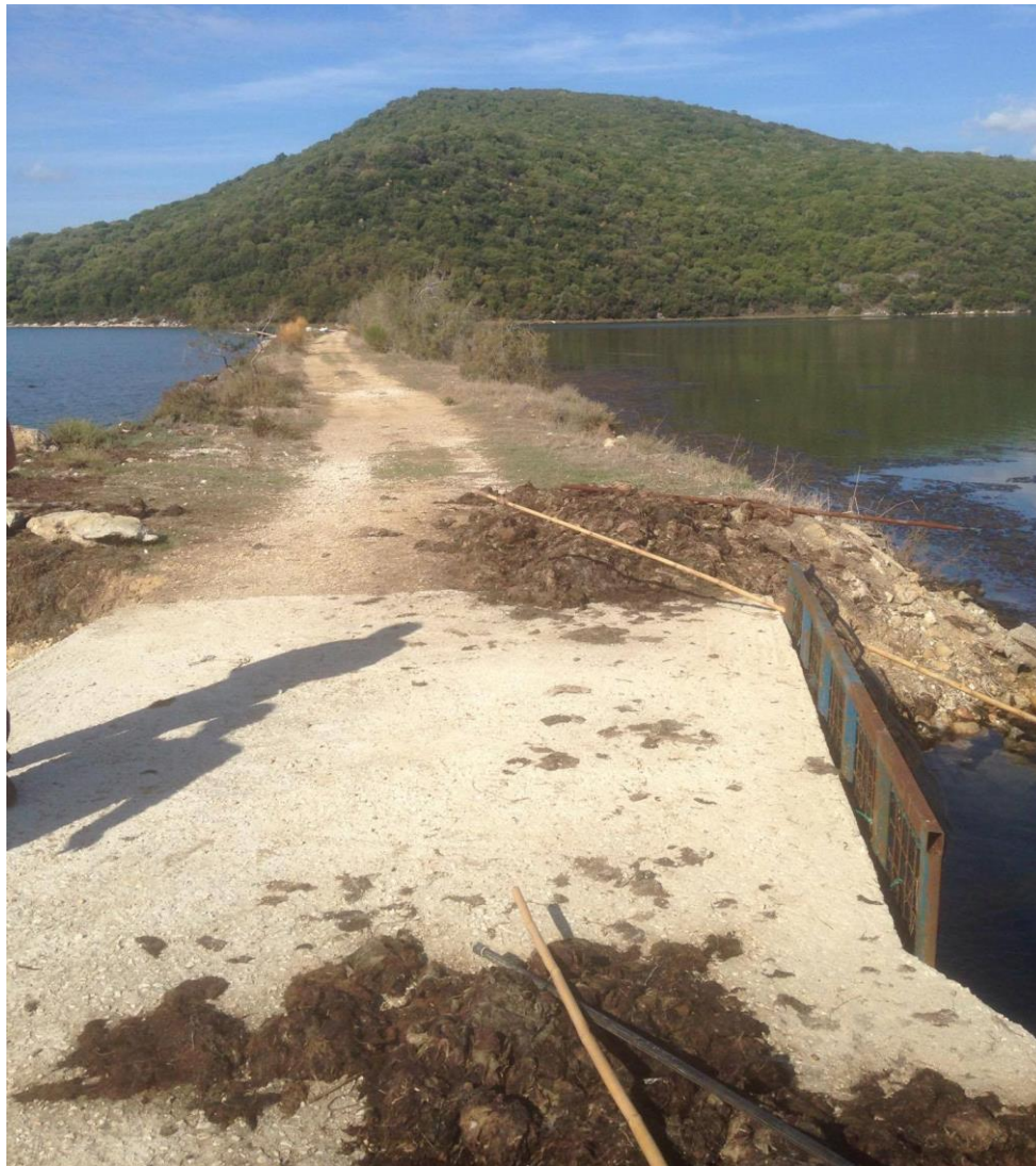
Εικόνα 4.1.5: Άποψη του τεχνητού αναχώματος από το νοτιότερο εσοδευτικό στόμιο.
