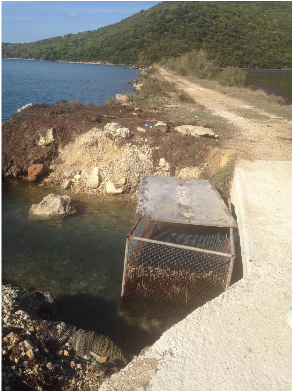
Εικόνα 4.2.3: Αποψη του τεχνητού αναχώματος από το νοτιότερο εσοδευτικό στόμιο. Κλωβός διατήρησης αλιευμένων καβουριών
