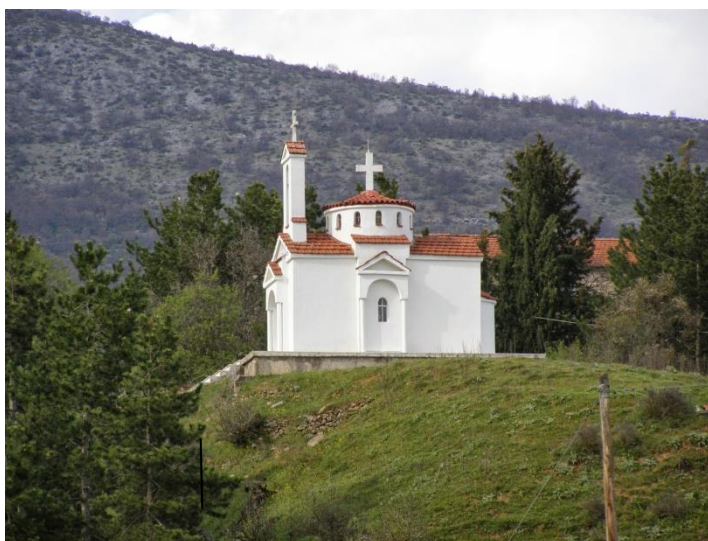
Εικόνα 14: Άποψη της εκκλησίας από το νότο. Από την ηλεκτρονική διεύθυνση του Μορφωτικού Συλλόγου Πολιτιστικού και Εξωραϊστικού Συλλόγου της Λεύκης “Άγιος Χριστόφορος”.
