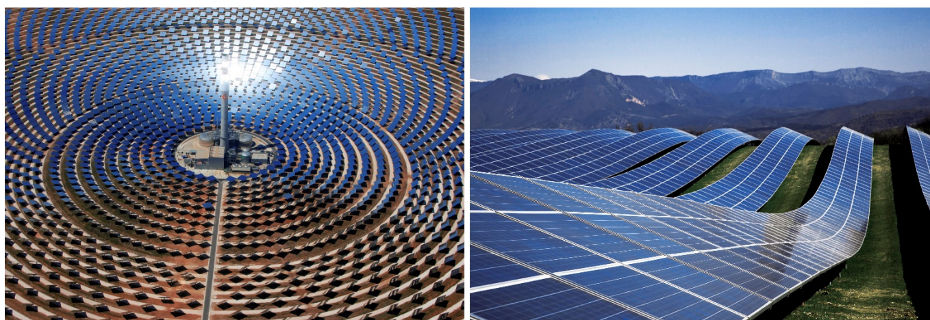
Εικόνα 1.15. (α) Εγκατάσταση συγκέντρωσης ηλιακής ακτινοβολίας στη Σεβίλλη της Ισπανίας. (β) Φωτοβολταϊκό πάρκο στο Les Mées της Γαλλίας.
