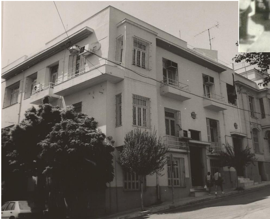
Εικόνα 9: Η πρόσοψη του κτηρίου στη συμβολή των οδών Καρυατίδων 6 & Καλλισπέρη 12.
