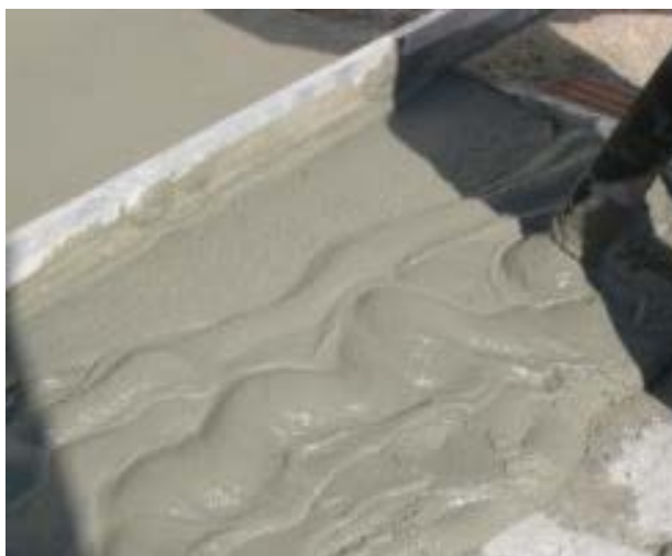
Εικόνα 3.2 Εφαρμογή κονιάματος στην επιπέδωση δαπέδων [11]
