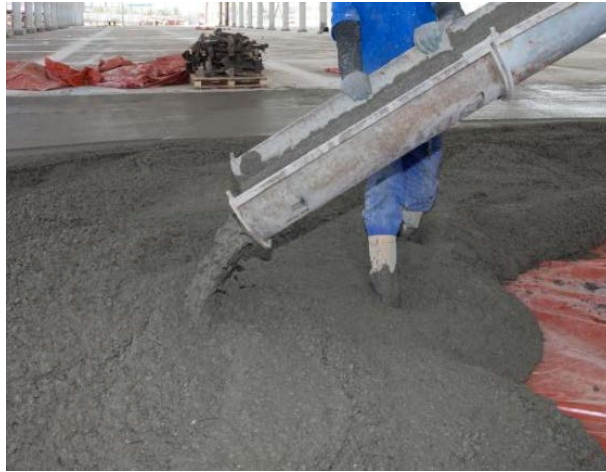
Εικόνα 3.1 Το σκυρόδεμα σε μια εφαρμογή εδαφόπλακας [11]
