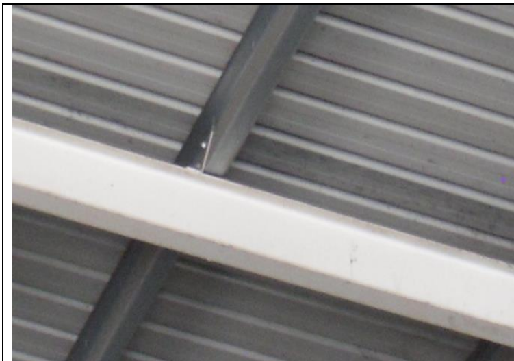
Εικόνα 2.5 : Σύνδεση τεγίδας Σύνδεσμος
