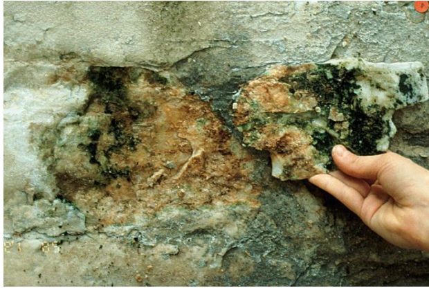
Εικόνα 1.21 :Ατμοσφαιρική διάβρωση
