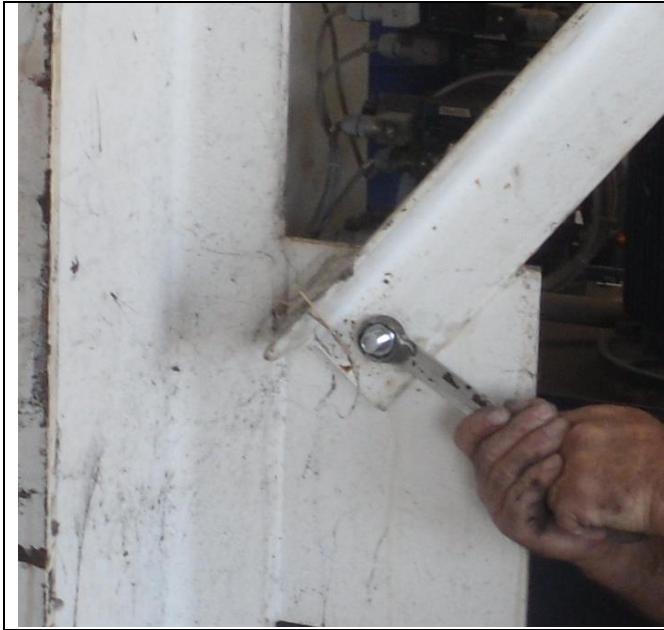
Εικόνα 2.4 : Σύνδεση αντιανεμίου Σύνδεσμος
