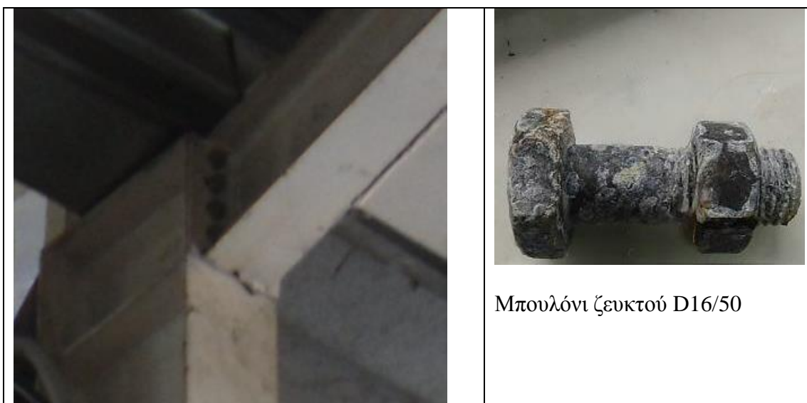
Εικόνα 2.2 : Σύνδεση ζευκτού (Σύνδεσμοι στύλου – δοκού)
