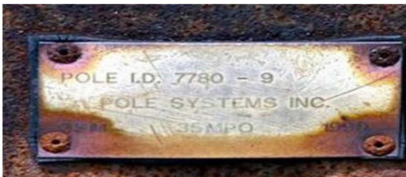
Εικόνα 1.15: Γαλβανική διάβρωση (χάλυβας, χαλκός)
