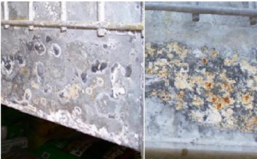
Εικόνα 1.14: Γαλβανική/διμεταλλική διάβρωση αρχικό/ προχωρημένο στάδιο
