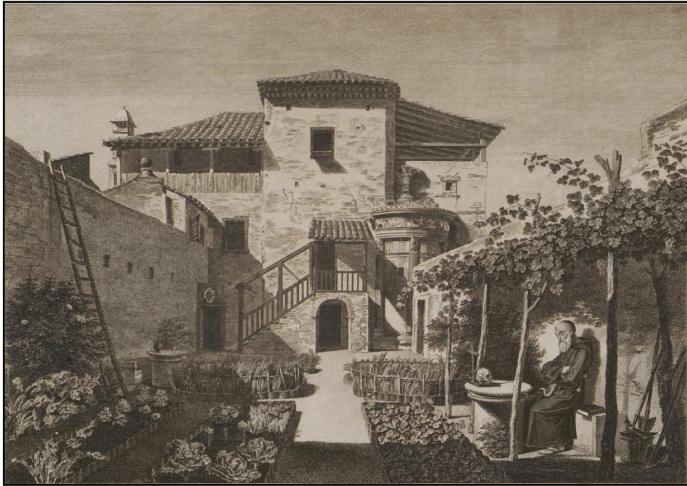
Εικ. 1.2 Το μνημείο του Λυσικράτους ιδωμένο από τον ξενώνα της μονής των Καπουτσίνων και ενσωματωμένο ως αρχιτεκτονικό μέλος στο οικοδόμημα. Διακρίνεται ο κήπος και ένας μοναχός (περ. 1762). Στο μοναστήρι, μεταξύ άλλων, φιλοξενήθηκε ο Chateaubriand στα 1806 και ο Byron στα 1810.
