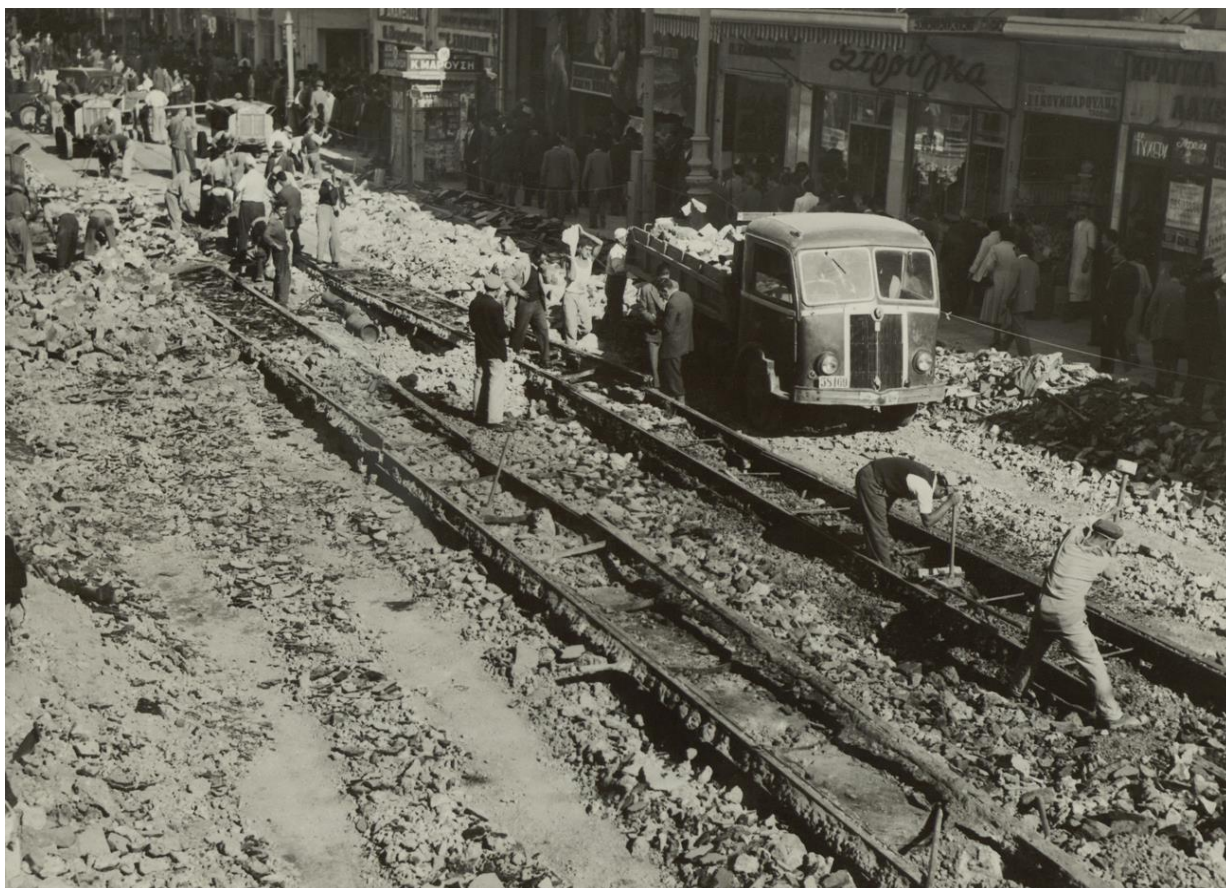
Εικόνα 40: Εργασίες αφαίρεσης τροχιοδρομικών γραμμών (τραμ) στην Αθήνα, 16 Νοεμβρίου 1953.
