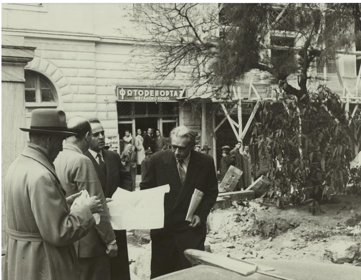
Εικόνα 41: Ο Υπουργός Δημοσίων Έργων, Κωνσταντίνος Καραμανλής, επιθεωρεί τα έργα αναμόρφωσης του περιβάλλοντος χώρου της Παλαιάς Βουλής. Διακρίνεται ο αρχιτέκτονας Παναγιώτης Μιχελής, Δεκέμβριος 1953.
