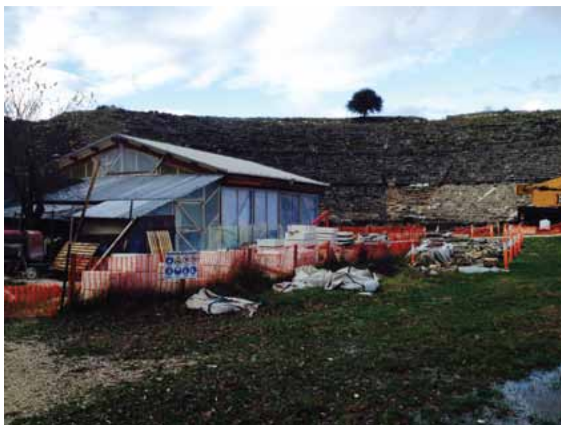
Εικόνα 23: Η εγκατάσταση του εργοταξίου για την αποκατάσταση του θεάτρου. Πηγή: Φωτογραφία της γράφουσας
