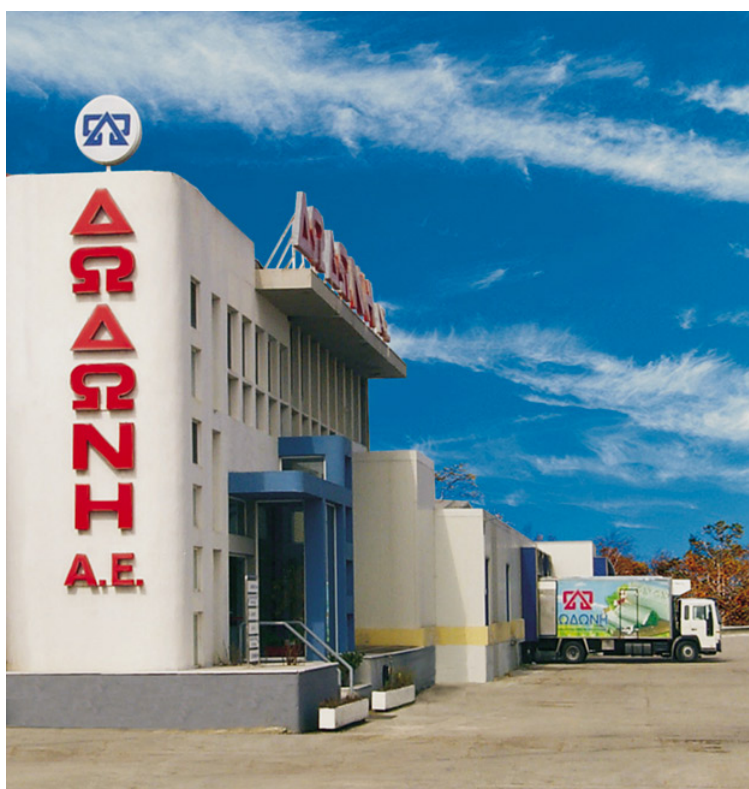
Εικόνα 33: Η Γαλακτοβιομηχανία Δωδώνη Α.Ε.
