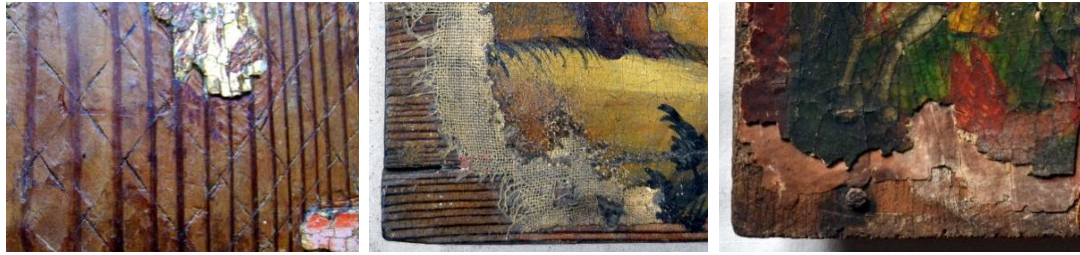
Εικόνα 13. Αριστερά: εγγάρια επιφάνεια ξύλινου υποστηρίγματος (α/α εικόνας: 25). Μέσο: ύφασμα μεταξύ προετοιμασίας και ξύλινου υποστηρίγματος (εικόνα '3'). Δεξιά: φύλλο χάρτου υπό την προετοιμασία (εικόνα '62').
