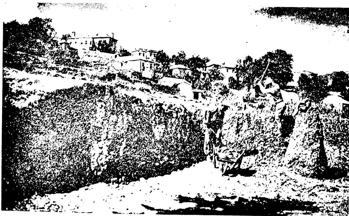
Διάνοιξη δρόμου στο Λαχανόκαστρο.
