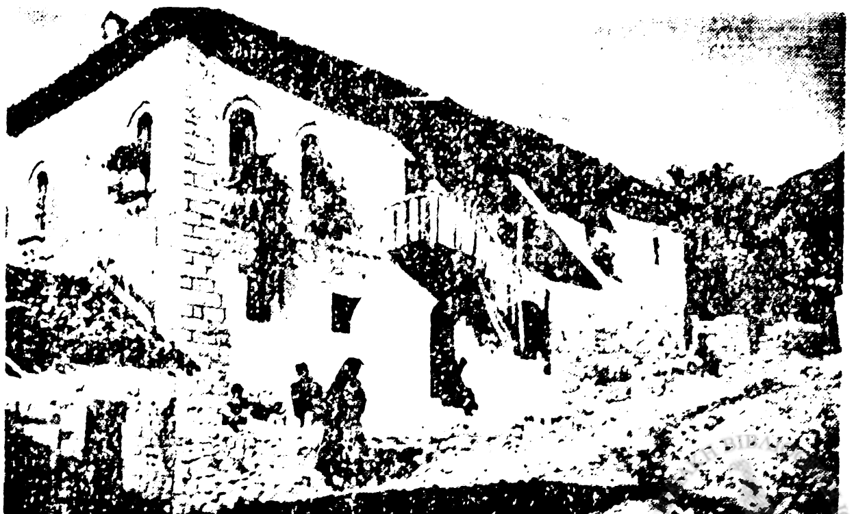
28 Το σπίτι της Ευρα - Βασιλικής στην Πλαίσιτσα (Πλαίσιον) Φιλιατών. (Άρχειον Άλεξ. Χ. Μαμμοπούλου).
