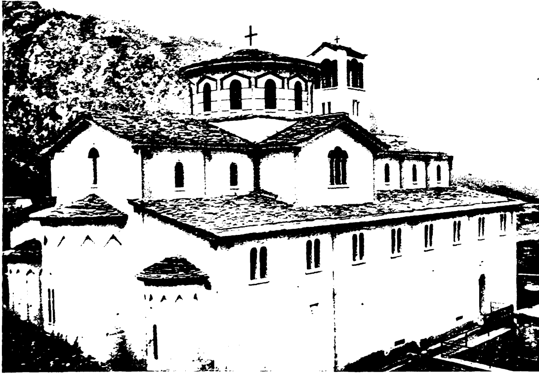
Ὁ Ναός τοῦ Ἁγίου Κοσμᾶ τοῦ Αἰτωλοῦ στήν Κόνιτσα. Τρίκλιτος Βασιλική μετὰ τρούλλου σταυροειδῆς. Ἡ στέγη μέ σχιστολιθικές πλάκες.
