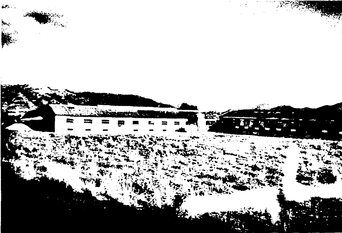
ΕΙΚΟΝΑ 46 : ΠΤΗΝΟΤΡΟΦΕΙΟ ΕΛΕΥΘΕΡΗΣ ΒΟΣΚΗΣ ΥΣΤΕΡΑ ΑΠΟ ΜΕΤΑΤΡΟΠΗ ΚΤΙΡΙΩΝ ΠΟΥ ΧΡΗΣΙΜΟΠΟΙΟΥΝΤΑΝ ΓΙΑ ΣΥΜΒΑΤΙΚΗ ΕΚΤΡΟΦΗ ΟΡΝΙΘΙΩΝ. ΔΙΑΚΡΙΝΟΝΤΑΙ ΟΙ ΘΥΡΕΣ ΕΞΟΔΟΥ ΤΩΝ ΟΡΝΙΘΙΩΝ.
