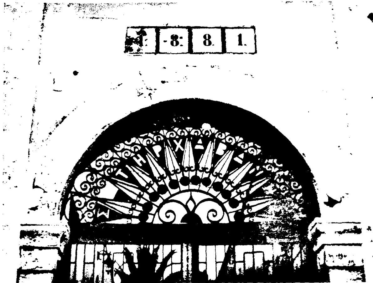
ΕΙΚΟΝΑ 5: Λεπτομέρεια του λίθινου τοξωτού ανοίγματος της θύρας του ιταλικού προξενείου (Φωτογραφία Ε. Μανοπούλου, 2009)
