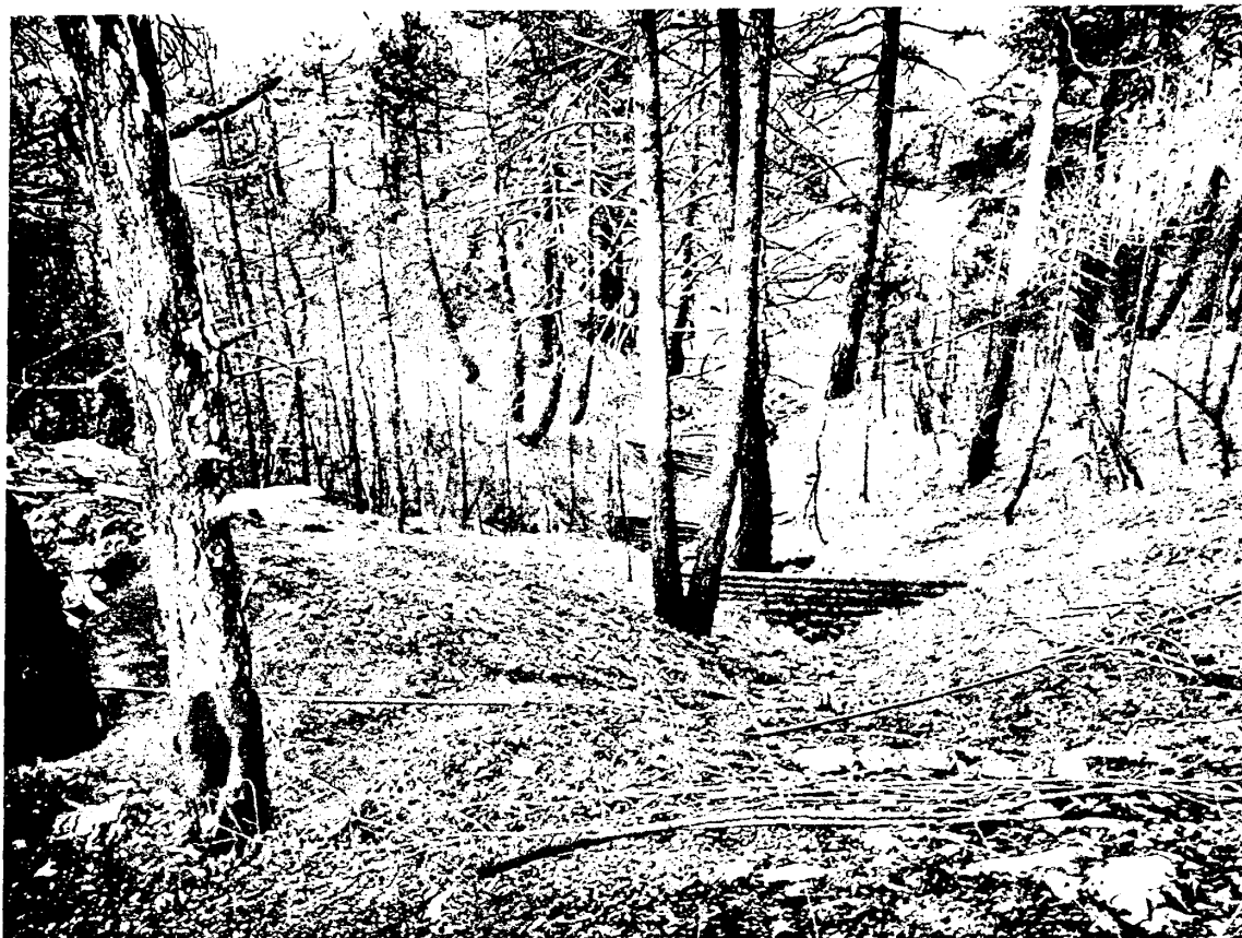
Εικ. 18 Διαχείριση καμένου ιστάμενου ξυλώδους όγκου και κατασκευή κορμοφράγματος στην ορεινή περιοχή του Δήμου Ζαχάρως μετά την πυρκαγιά του έτους 2007. Πηγή: ΕΘΙΑΓΕ, 2007.
