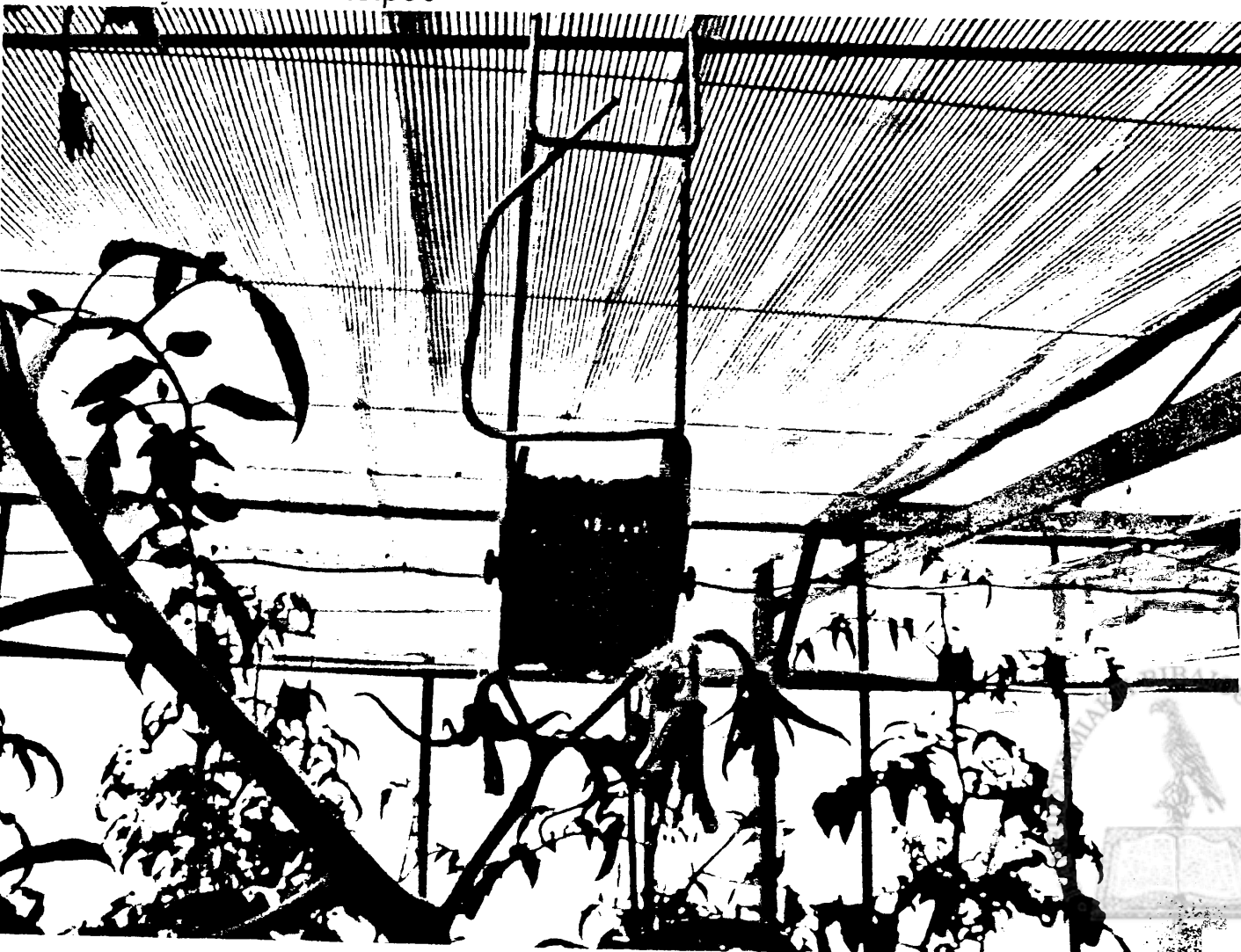
Εικόνα 14. Σύστημα υδρονέφωσης στην οροφή του θερμοκηπίου στις αταστάσεις του ΤΕΙ Ηπείρου
