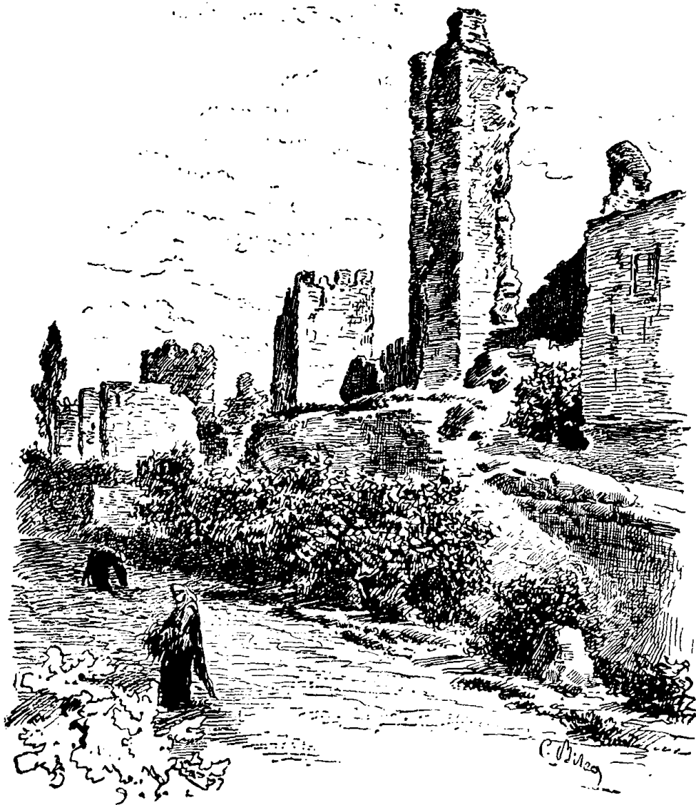
Intérieur des murs.
