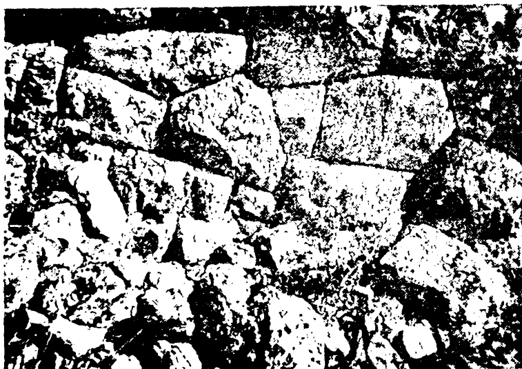
Εικ. 5. - Τμήμα τῆς ἀνατολικῆς πλευρᾶς τοῦ πολυγωνικοῦ τείχους.
