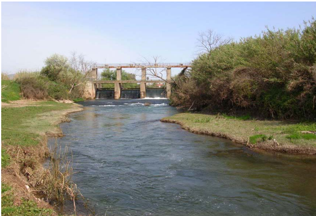
Εικόνα 4: Το φράγμα του Πάμισου
