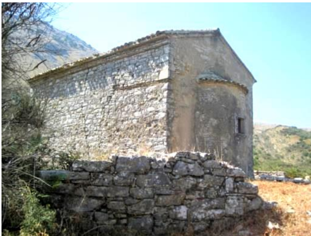
198. Ι.Ν. Αγίου Γεωργίου: ΝΑ όψη ναού, σωζόμενο τμήμα περιβόλου
