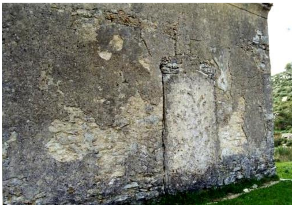
199. Ι.Ν. Αγίου Γεωργίου: Β τείχος ναού, σφραγισμένη θύρα εισόδου
