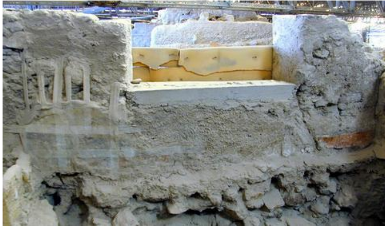
Εικ. 68. Ακρωτήρι, Θήρα. Κτήριο Β, Δωμ. 1, α' όροφος: βόρειο παράθυρο.
