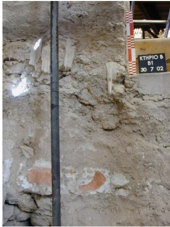
Εικ. 76. Ακρωτήρι, Θήρα. Κτήριο Β, Δωμ. 1, α' όροφος: δυτικό τμήμα βορείου τοίχου. Τμήμα παλαιότερης τοιχογράφησης και πρασινωπή ουσία επικάλυψης του τοίχου.
