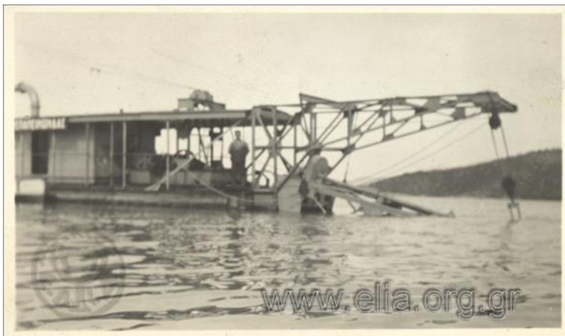
Φωτογραφία 19. Αποξηραντικά έργα στο έλος Λεσίνι, η αναρροφητική βυθοκόρος Επαμεινώνδας επί τω έργω. Πηγή: Αρχείο ΕΛΙΑ 1934-1940.
