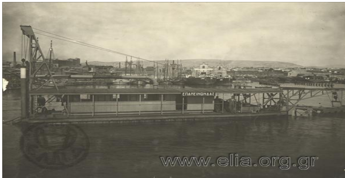
Φωτογραφία 8. Αποξηραντικά έργα στο έλος Λεσίνι η αναρροφητική βυθοκόρος Επαμεινώνδας, σχεδιασμένη από τον Μιχαήλ Συκώκη, στο λιμάνι του Μεσολογγίου Πηγή: Αρχείο ΕΛΙΑ 1934-1940.
