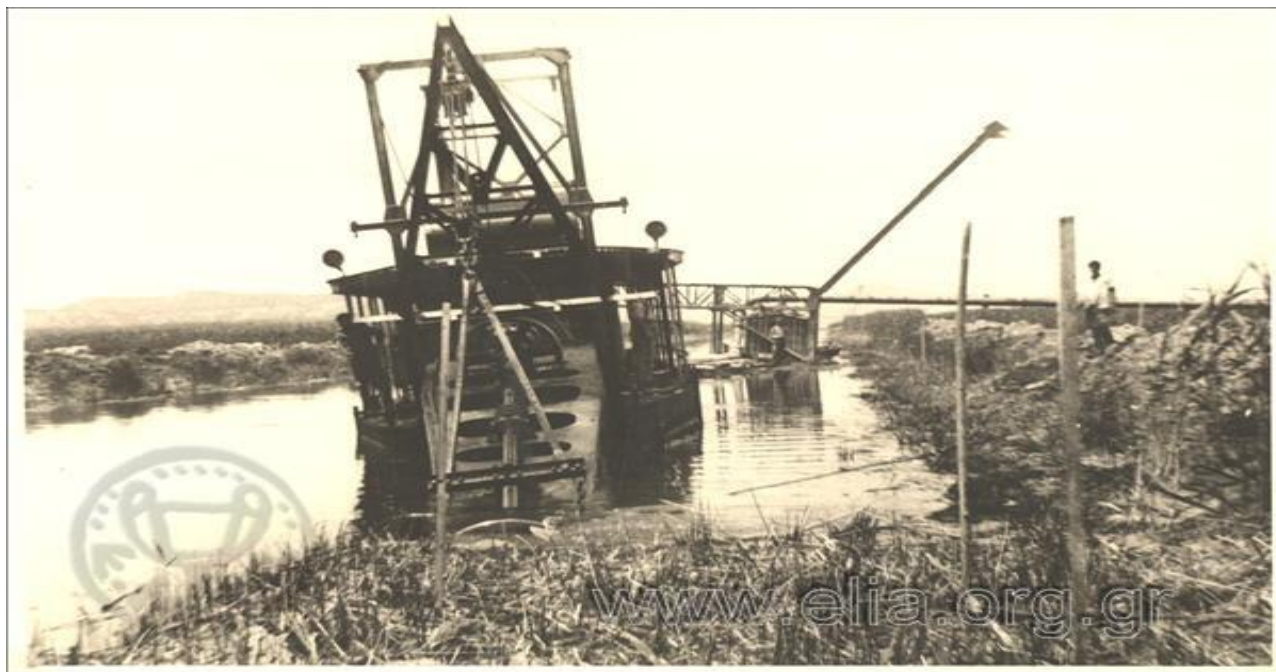
Φωτογραφία 9. 322 Αποξηραντικά έργα στο έλος Λεσίνι η βυθοκόρος Επαμεινώνδας, σχεδιασμένη από τον Μιχαήλ Συκώκη, ενσκάπτει την κύρια συλλεκτήριο τάφρο προς το αντλιοστάσιο. Πηγή: Αρχείο ΕΛΙΑ 1934-1940.
