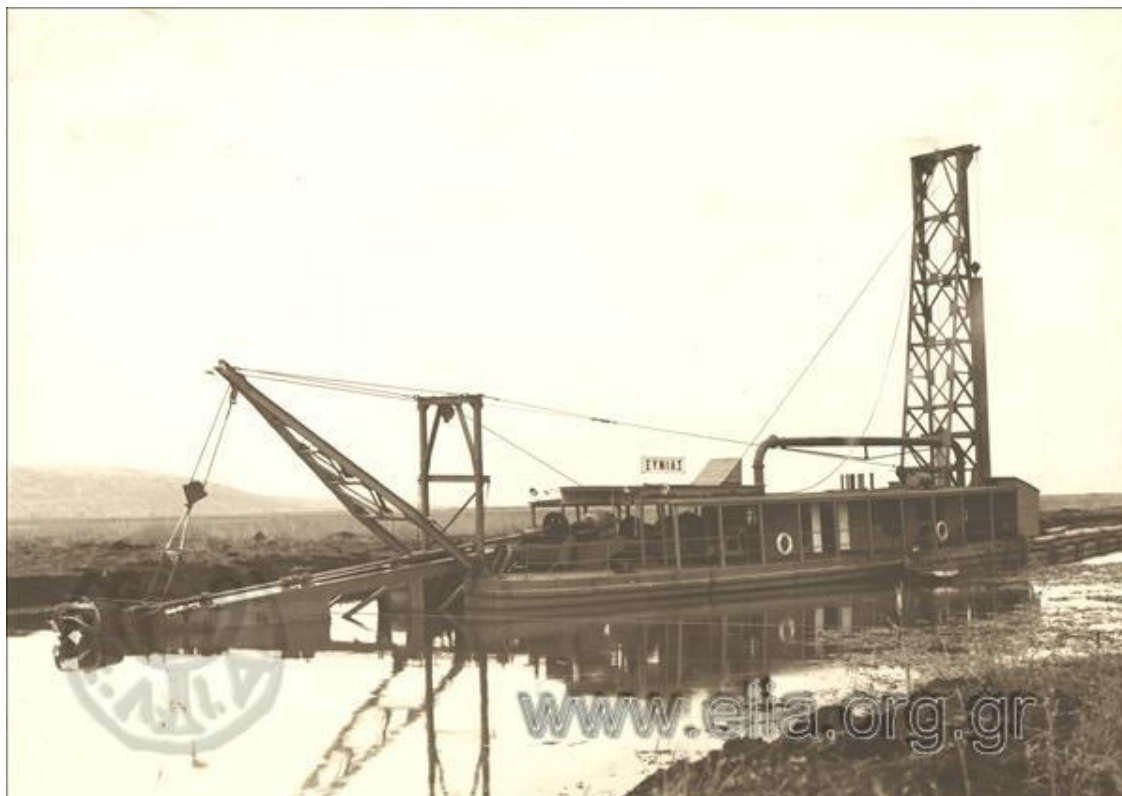
Φωτογραφία 23. Αποξηραντικά έργα στη λίμνη Ξυνιάδα (Φθιώτιδα): η βυθοκόρος "Ξυνιάς" κατά τη διάρκεια εκσκαφής της κύριας αποχετευτικής διώρυγας. Πηγή: Αρχείο ΕΛΙΑ 1938-1940.
