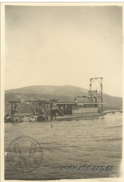
Φωτογραφίες 17-18, Εικόνες εξωφύλλου. Αποξηραντικά έργα στο έλος Λεσίνι, η αναρροφητική βυθοκόρος Επαμεινώνδας επί τω έργω. Πηγή: Αρχείο ΕΛΙΑ 1934-1940.
