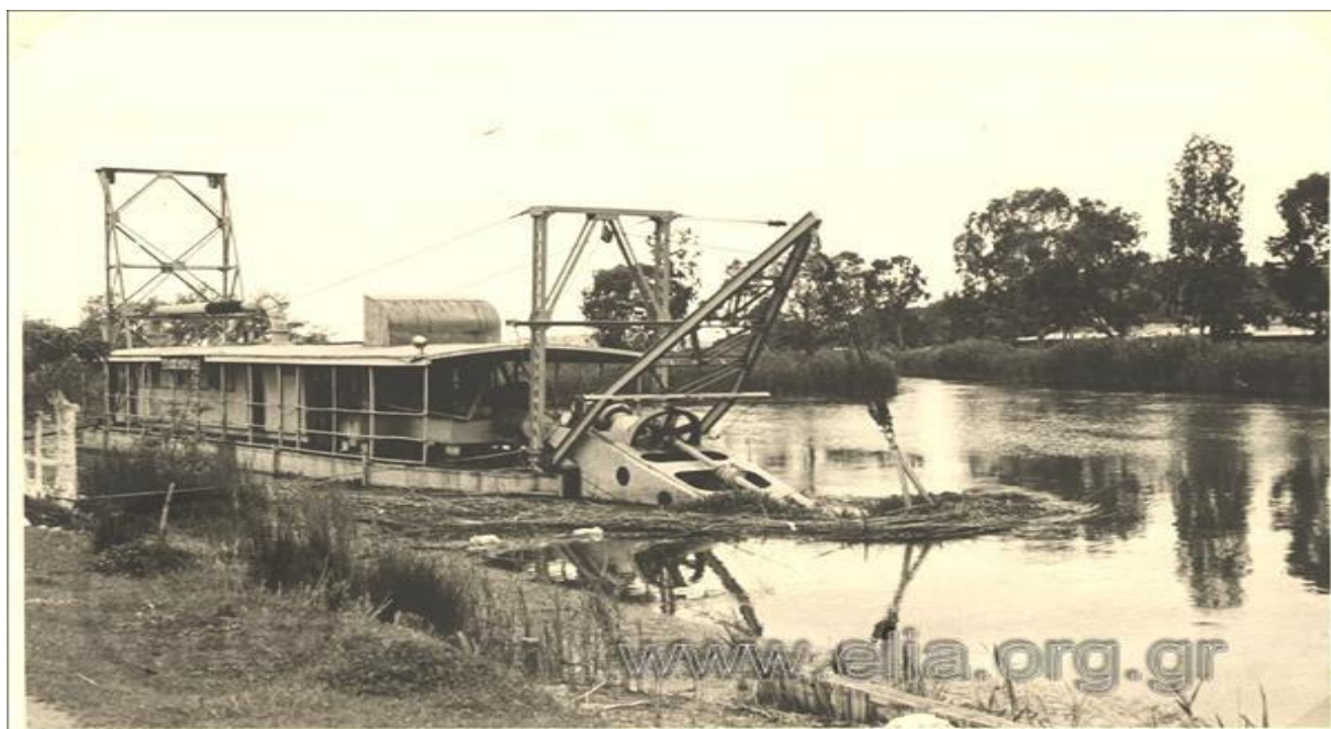
Φωτογραφία 10. 326 Αποξηραντικά έργα στο έλος Λεσίνι η βυθοκόρος Επαμεινώνδας, σχεδιασμένη από τον Μιχαήλ Συκώκη, επί τω έργω. Πηγή: Αρχείο ΕΛΙΑ 1934-1940.
