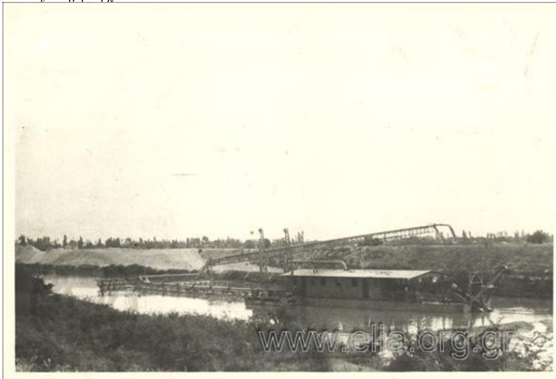
Φωτογραφία 21. Αποξηραντικά έργα στη λίμνη Γιαννιτσών, εργασίες διευθέτησης της περιφερειακής διώρυγας της λίμνης: η βυθοκόρος "Νέστος" επί τω έργω. Πηγή: Αρχείο ΕΛΙΑ 1935-1936.
