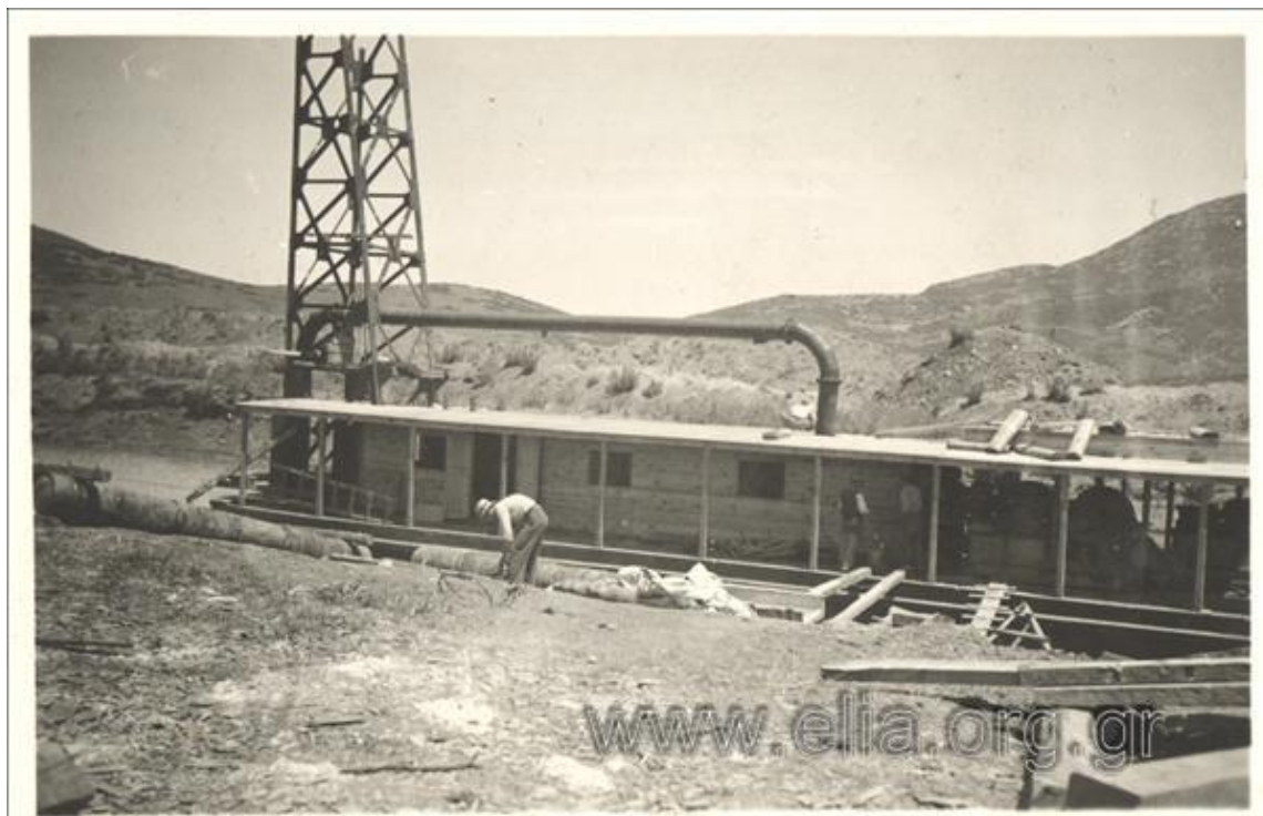
Φωτογραφία 22. Αποξηραντικά έργα στη λίμνη Ξυνιάδα: συναρμολόγηση και τοποθέτηση των μηχανισμών της βυθοκόρου "Ξυνιάς", σχεδιασμένης από τον Μιχαήλ Συγκώκη. Πηγή: Αρχείο ΕΛΙΑ 1938-1940.
