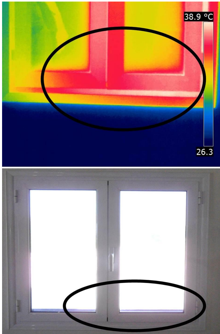
Εικόνα 49. Έλεγχος κουφωμάτων Α
