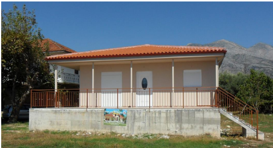
Εικόνα 37. Μη συμβατική κατασκευή
