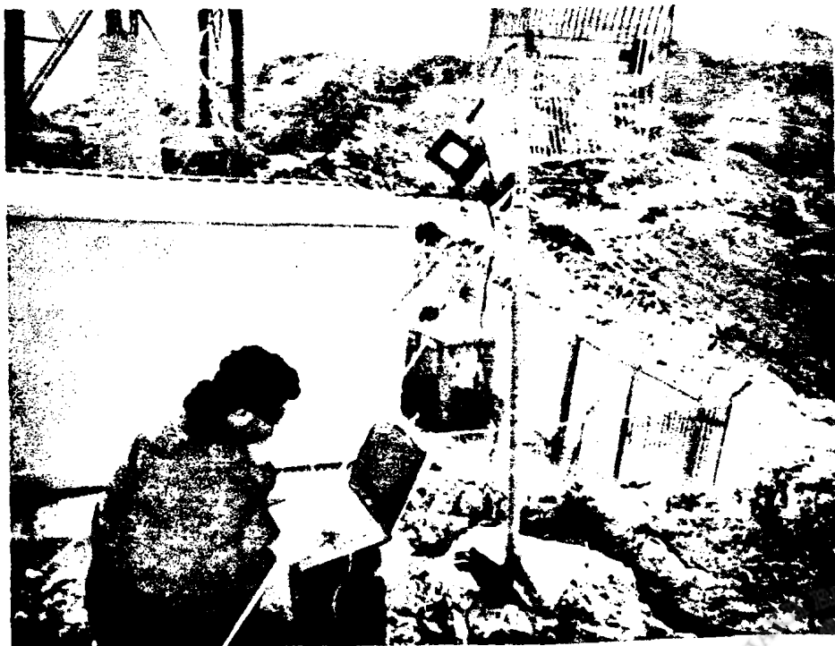
Εικόνα 61. Διαδικασία ευθυγράμμισης κεραίας
