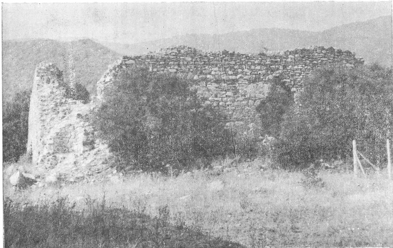
Εικ. 4. Το νότιο τείχος του ρωμαϊκού σταθμού Pennana.
