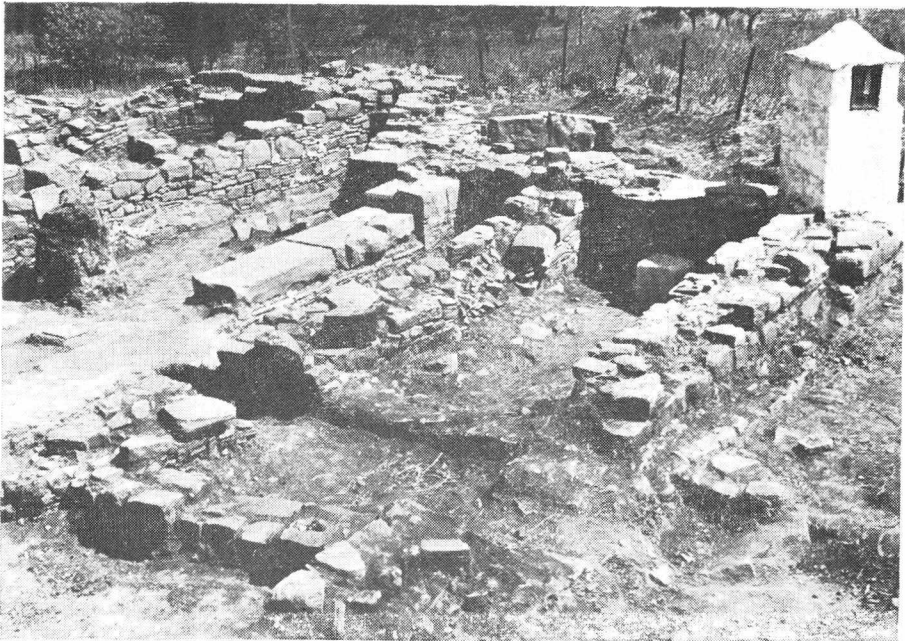
β. Καθώς η ανασκαφή συνεχίζεται στο νότιο κλίτος
