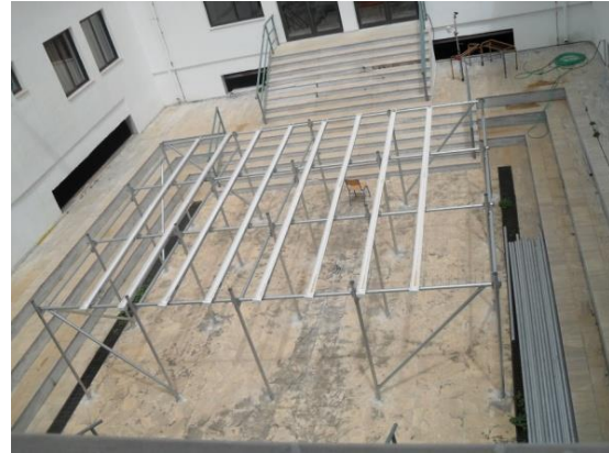
Εικόνα 12: Ολοκλήρωση κατασκευής του σκελετού της πέργολας
