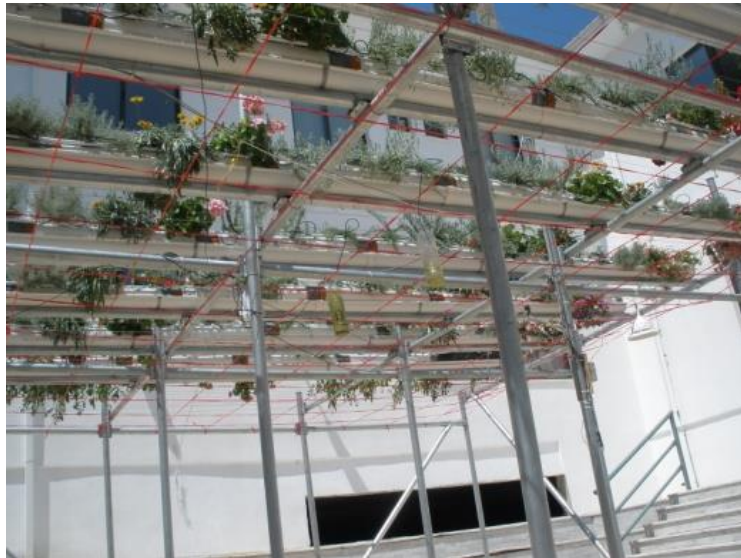
Εικόνα 40: Κόκκινο νήμα τοποθετημένο ακριβώς κάτω από τους φυτευτικούς φορείς
