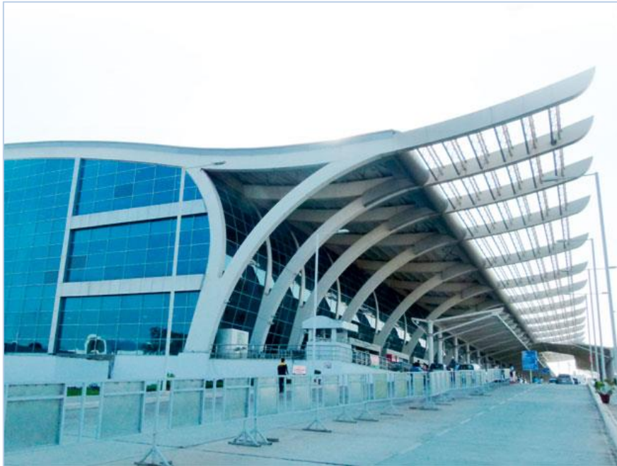
Εικόνα 57: Πέργκολα στον τερματικό σταθμό του αεροδρομίου της πολιτείας Γκόα της Ινδίας (πηγή: ssmb.in/goa-airport/ )
