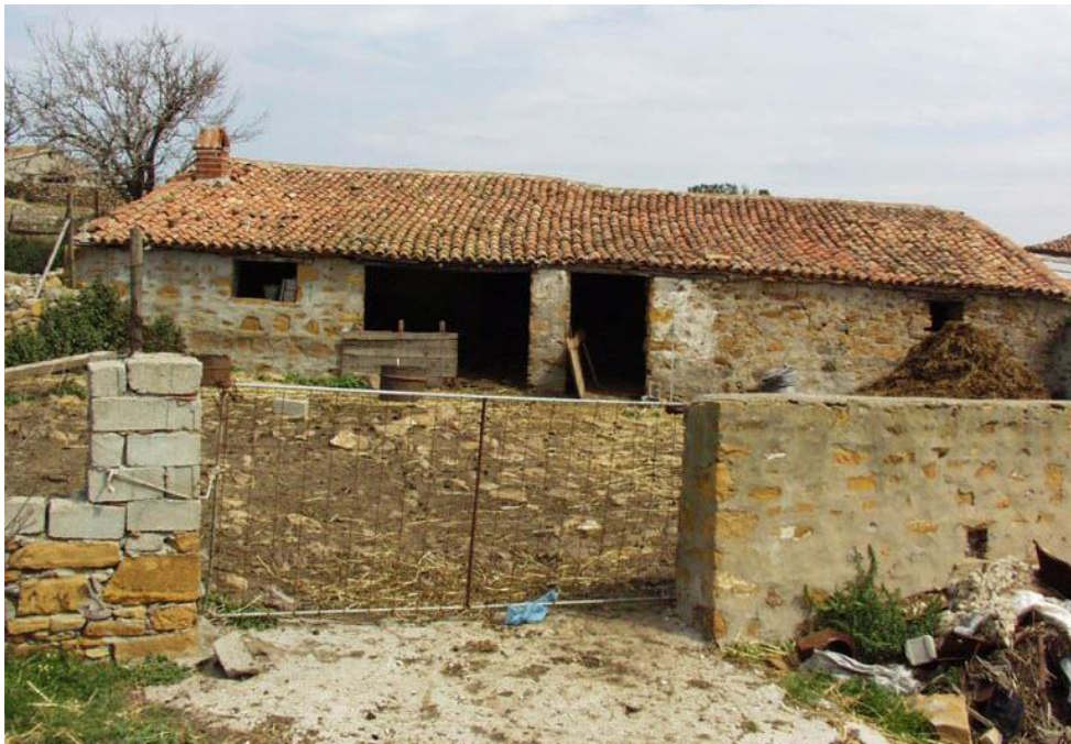
(6), Μάντρα με κιαχιαδόσπιτο στο σύμπλεγμα σταυλικών εγκαταστάσεων στην περιοχή της Κρηνίδας, 2001, όπ.π.
