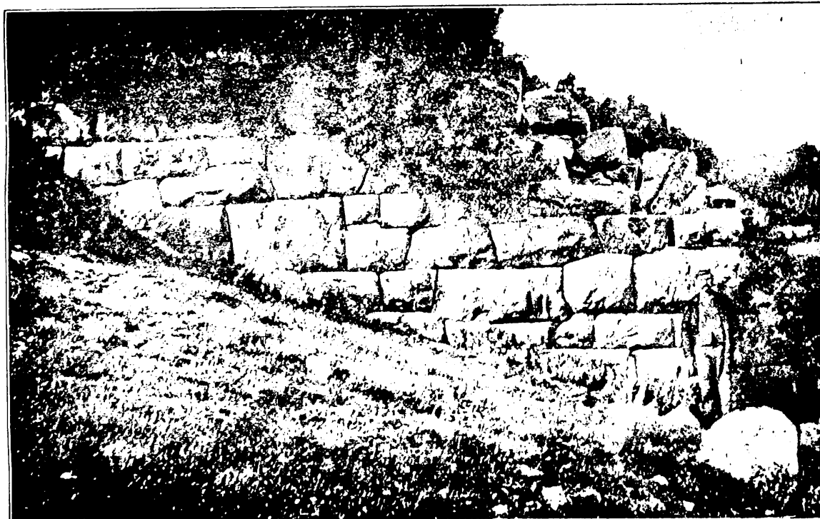
2. Außenseite der Mauer in Emplektontechnik im Südwesten von Larisa Kremaste
