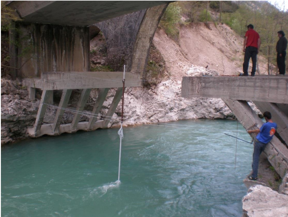
Σχήμα 15. Συνολική κατασκευή του συστήματος μέτρησης της ταχύτητας του νερού
