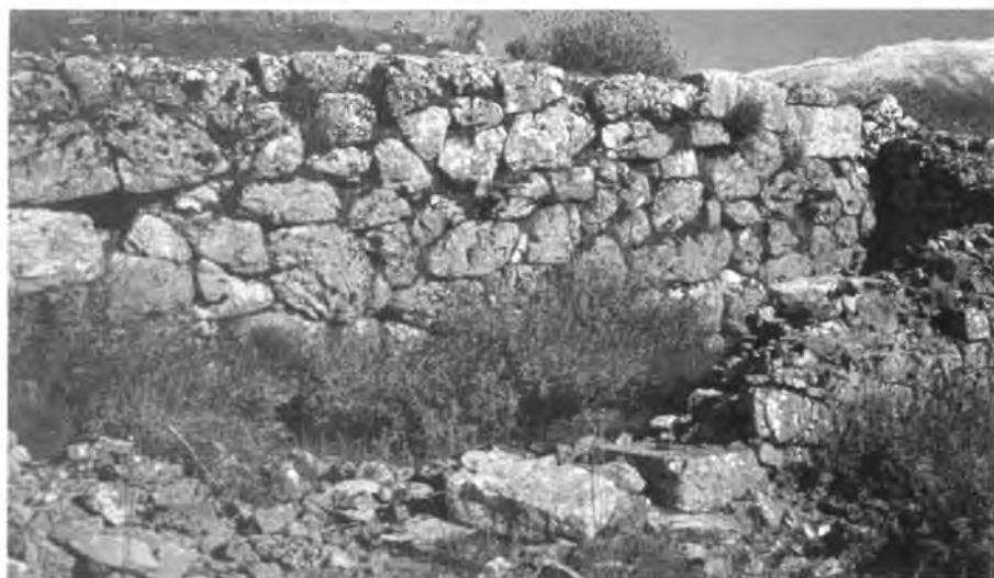
Εικόνα 26 α-β: Μ. Γαρδίκι (Πασσαρών). Αποψη του νότιου και του ανατολικού τείχους.
